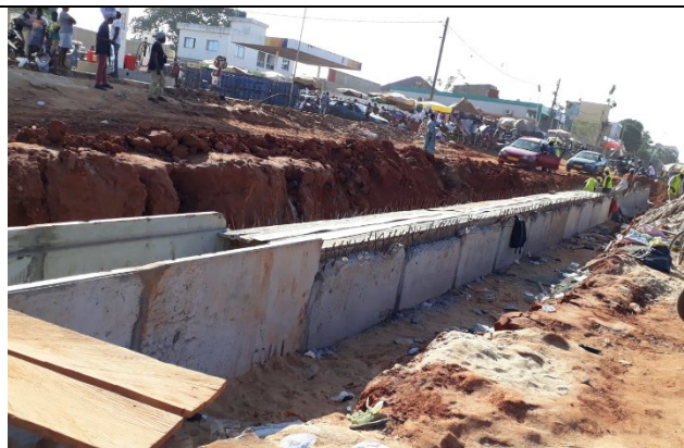
Großes Straßenbauprojekt in Lomé
